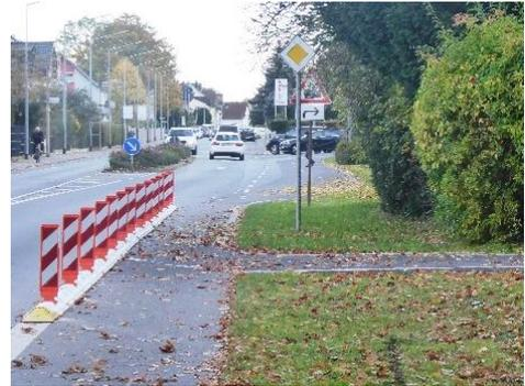
Abbildung 7: Trennelemente Hainer Chaussee
